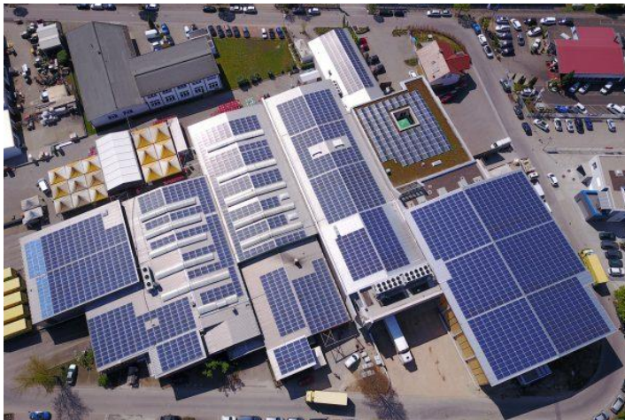
Dachfläche mit Photovoltaikanlage: Bild: Rinklin Naturkost GmbH
